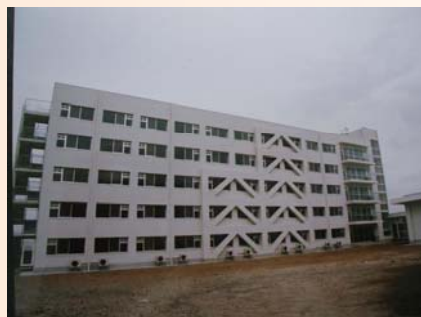
学生寄宿舍(水哉寮) 耐震補強・機能改修(平成21年度竣工)
