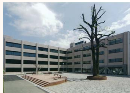
工学部E1棟 耐震補強・機能改修(平成23年度竣工)
