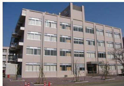
工学部W3棟 耐震補強・機能改修(平成21年度竣工)
