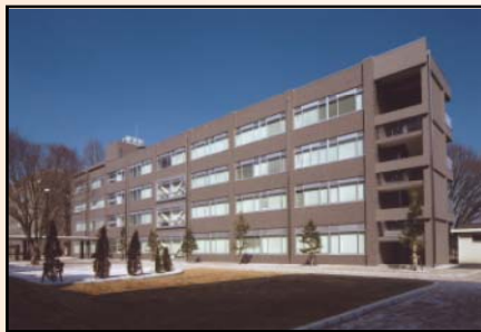
教育学部C棟 耐震補強・機能改修(平成21年度竣工)
